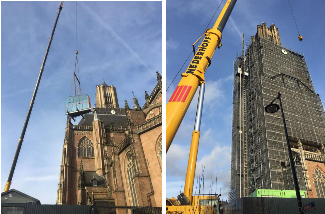
Foto's: Het plaatsen van de eerste glazen balkons bij de Eusebius. © DG
